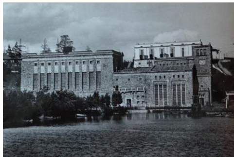
Здание Кондопожской ГЭС является памятником архитектуры
